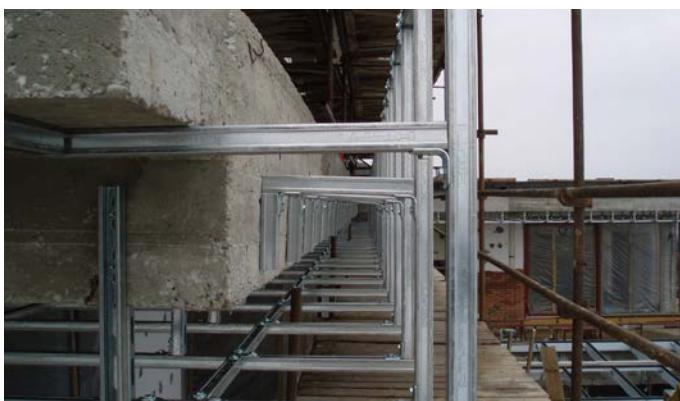
Rodinný dům - Střední Slovensko, podpůrné konstrukce
