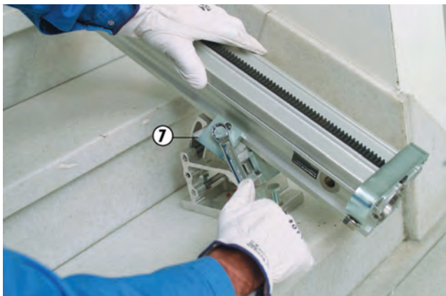
Τοποθέτηση ποδιού ράγας με πόδι λοξής και ορθογώνιας κοπής
